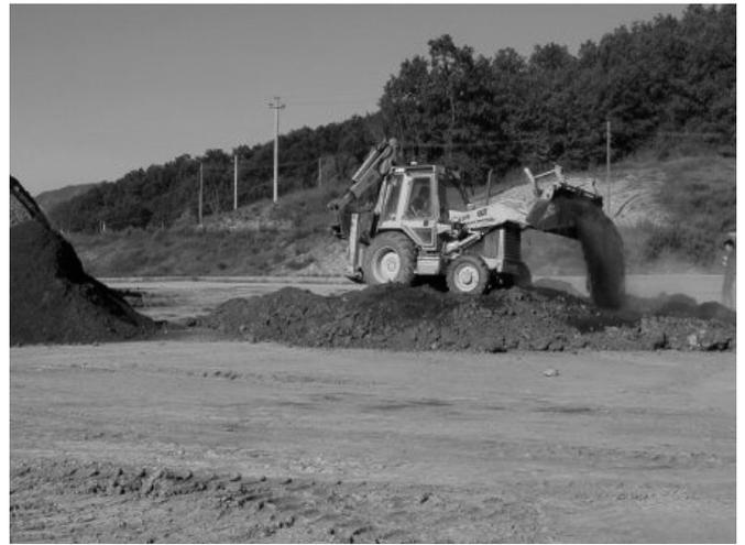
Foto 2 – Miscelazione della FOS al materiale di cava per la costituzione dei substrati di ripristino
